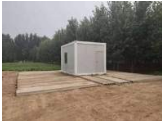
照片 3-6 3#井地上泵房
